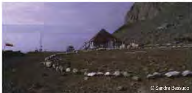
Fotos 1: Desde el año 2006, la Armada cuenta con un nuevo edificio para el Puesto de Vigilancia.
